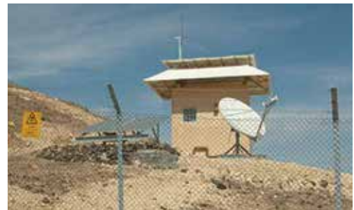
الشكل (١٤): محطة رصد زلزالي
