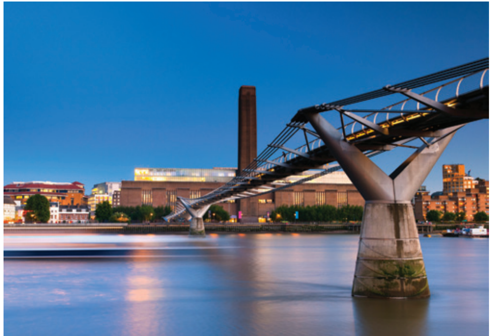
الصورة ٦-٧. أُغلق جسر الألفية للمشاة «المهتز» في لندن لمدة عامين تقريباً لتصحيح المشكلات التي حدثت بسبب الرنين.
