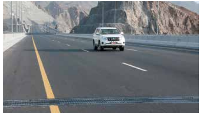
الصورة ٦-٢ فاصل تمدد في جسر
