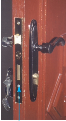
الشكل (٩) : برغي تثبيت الأسطوانة .
