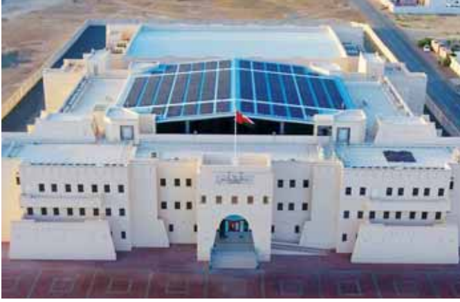
الصورة ١١-٣ مجموعة خلايا شمسية لإنتاج الطاقة الكهربائية في مدرسة السلطان قابوس بالبريمي، ضمن مشروع الطاقة الشمسية في مدارس السلطنة
