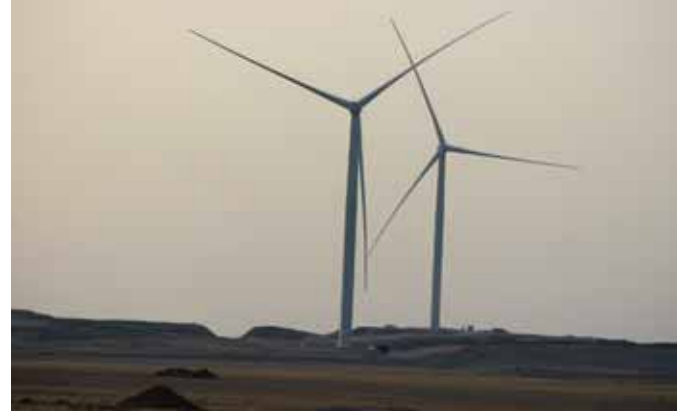
الصورة ١١-٤ توربينات هوائية ضخمة في محطة ظفار لطاقة الرياح تنتج طاقة تلبّي حاجة 16 ألف منزل من الكهرباء
